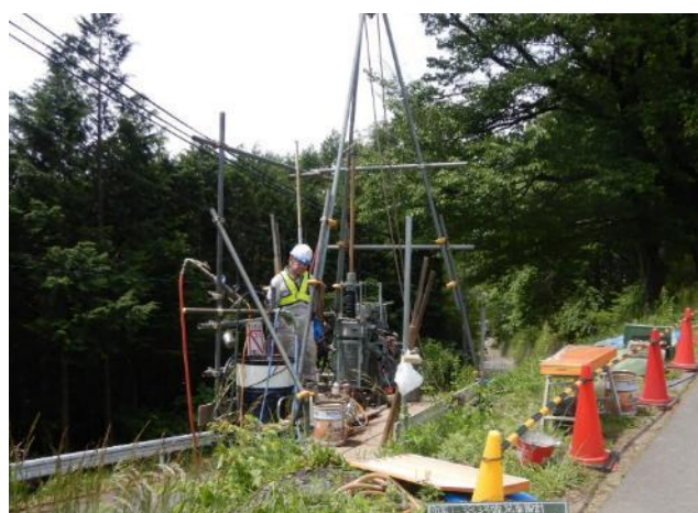
地質調査：ボーリング調査
