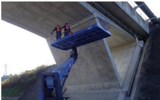
橋梁点検：外観変状調査
