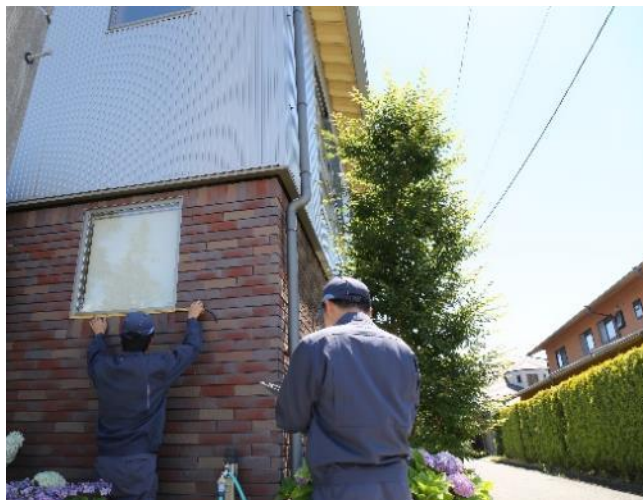
物件調査：建物
