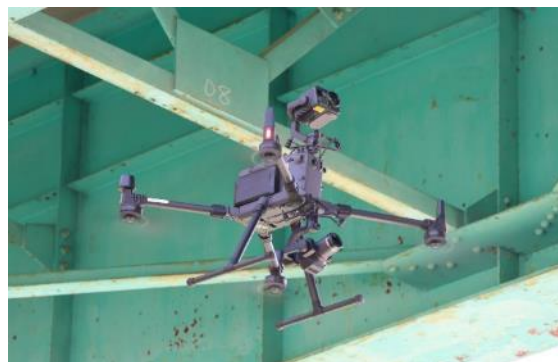
U A V による橋梁点検
