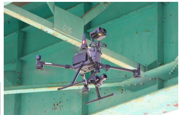
UAVによる橋梁点検
