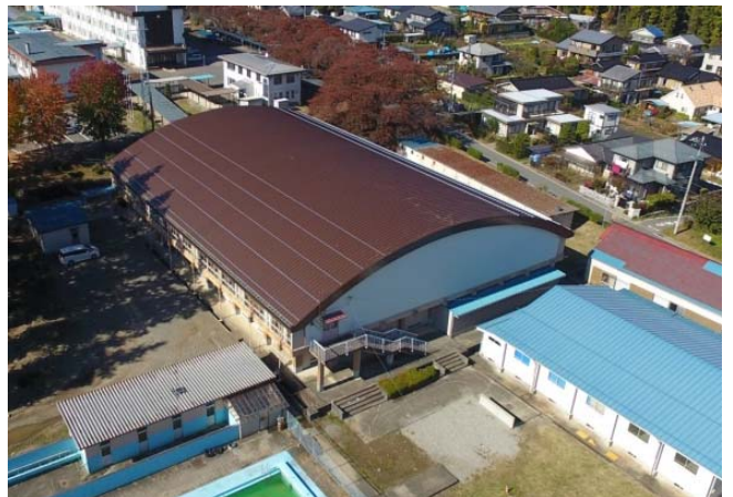
駒ヶ根工業高等学校体育館改修工事監理
