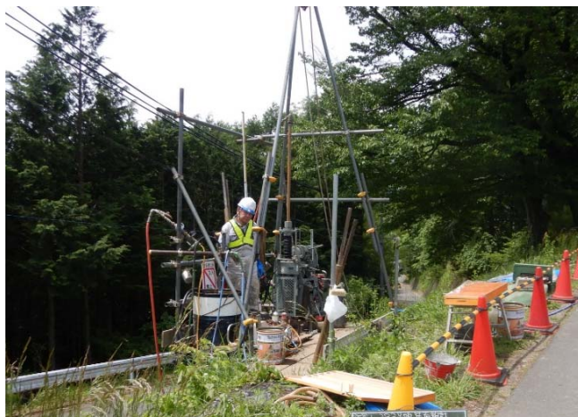
地質調査：ボーリング調査
